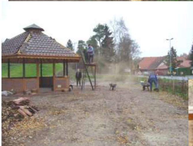
Endlich am 18.11.2006 Das Dach wird gedeckt
