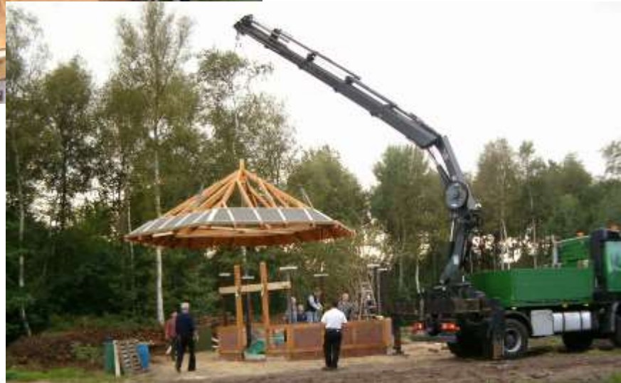
15.09.06: Das Dach wird dicht gemacht
