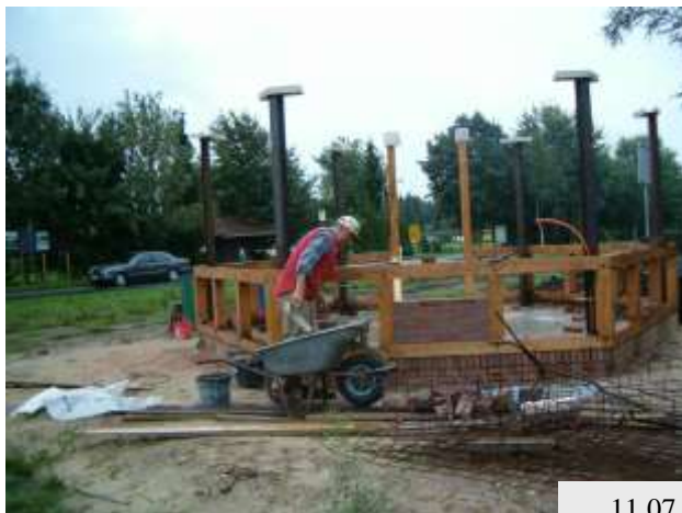
05.07.06: Beton- und Stahlfundament
